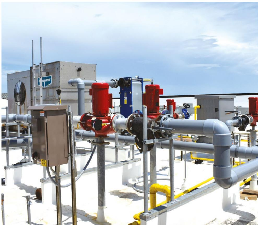
El CPVC Corzan® cumple con los estrictos requisitos de temperatura, presión y tamaño de los sistemas comerciales de calefacción y refrigeración.
